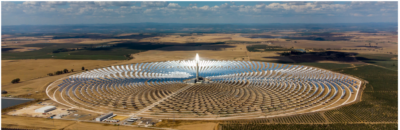
CENTRALE GEMASOLAR - ESPAGNE
